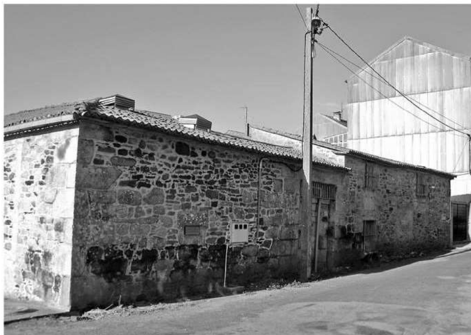
Parte posterior da edificación
